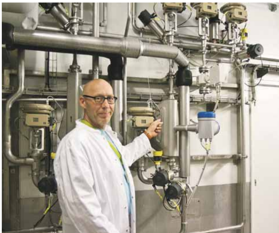
Project Coordinator Lars Lundgaard, Novozymes A/S: - Siden installeringen af Krohne Optimass 6400 har vi ikke haft produktionsstop på grund af at flowmålerne „tilter“. Vor opetid er blevet forbedret, og opstarten er også blevet hurtigere.
