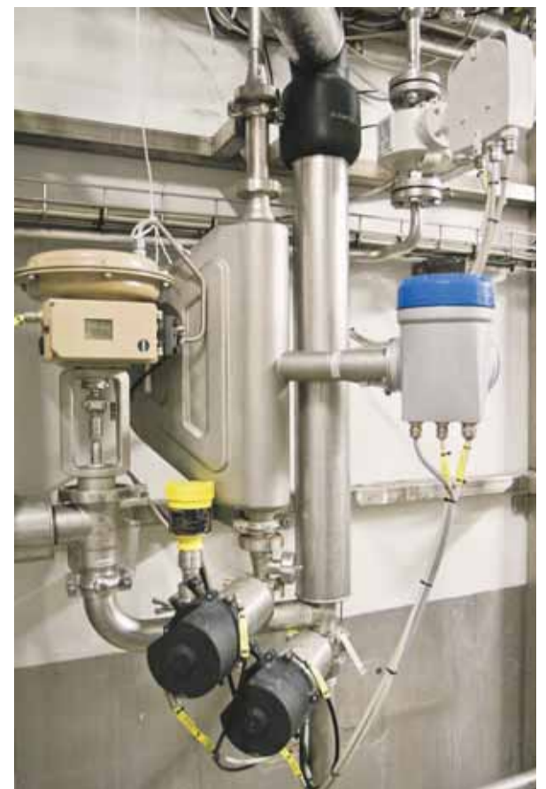
Krohne Optimass 6400 er verdens første Coriolis masseflowmåler med den avancerede Entrained Gas Management (EGM), der tillader målinger med gasindhold op til 100 %.
